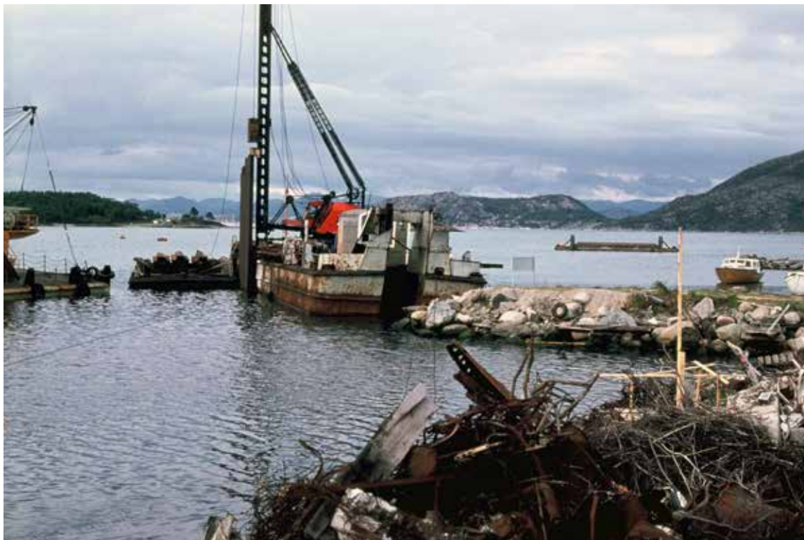
Dette bildet er fra den første pelingen for å lage bassenget for byggingen av Ekofisk tanken i 1971.
